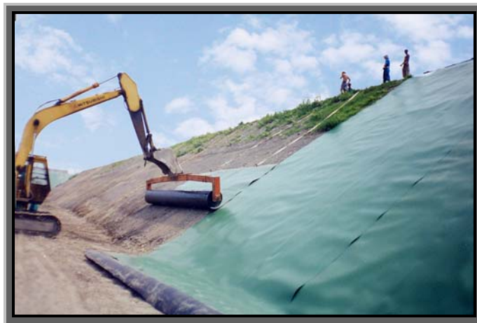
Hình 3.7 - Lót lớp chống thấm cho bãi chôn lấp
