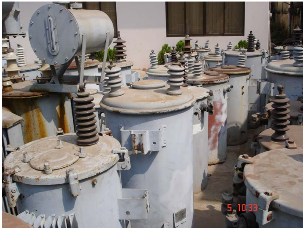
Hình 2.4. – Tụ điện được lưu giữ ngoài trời tại một chi nhánh điện lực
